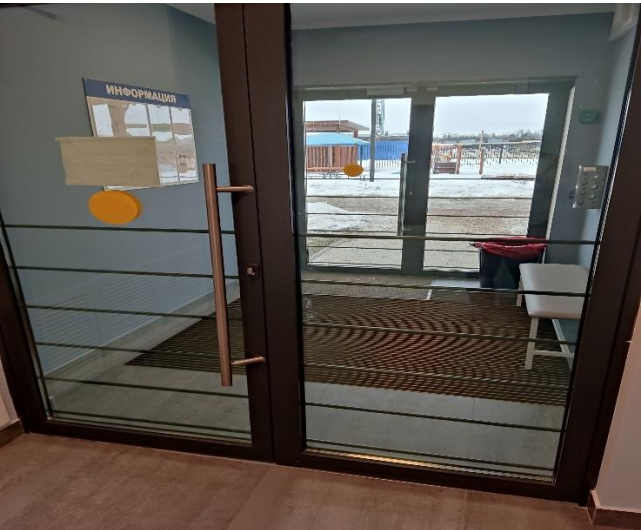
Фото 4 Тамбур главного входа
